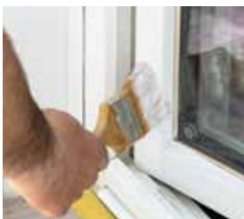
dřevo | renovace oken
